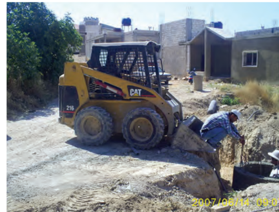
الأشغال في مشروع الصرف الصحي والطرقات الداخلية
