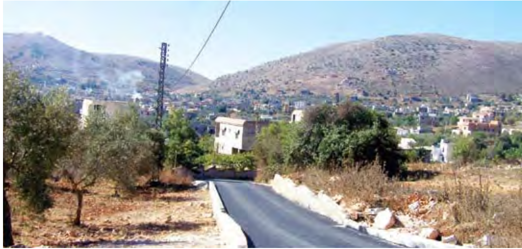
رصف الطرق الداخلية
