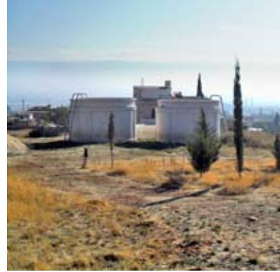
خزانات المياه التي تغذي البلدة
